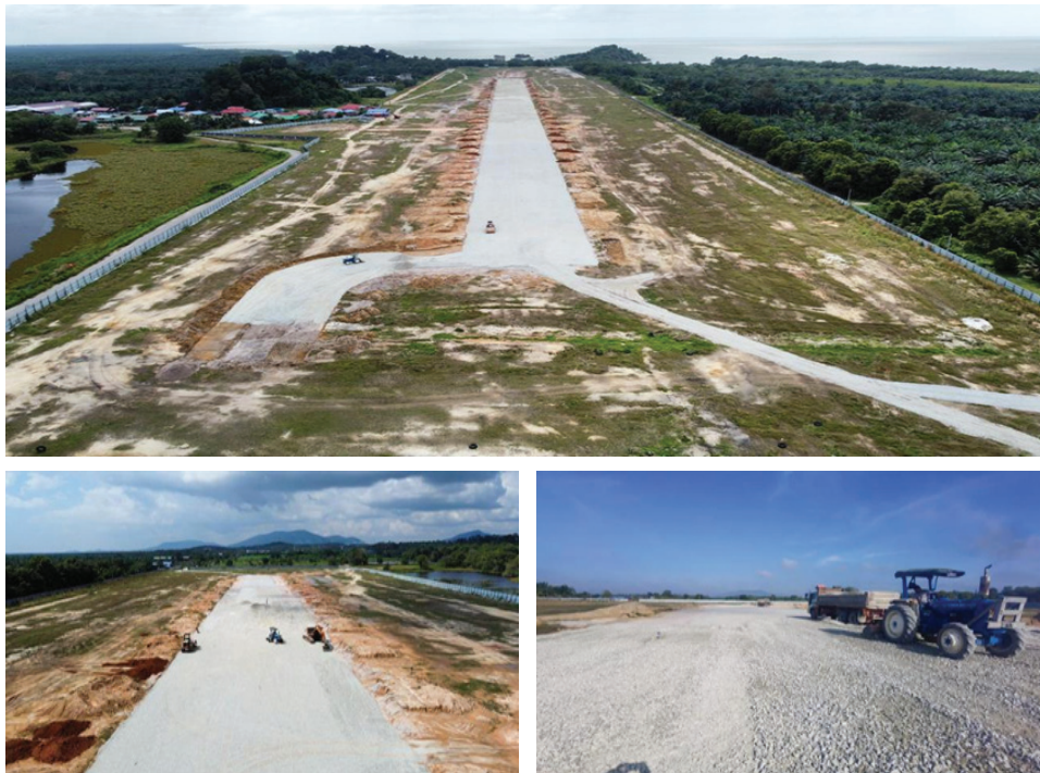
Foto 8.2 : Pembangunan Pusat Teknologi Aeronautik di Tanjung Laboh
